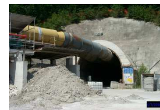
SCAVO DI GALLERIE
